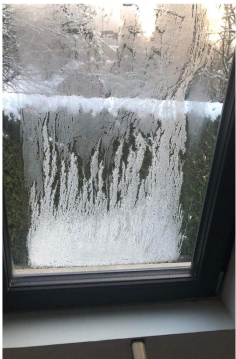
СКРЕЖ при Стъклопакет с TPS дистанционер на Ролпласт
