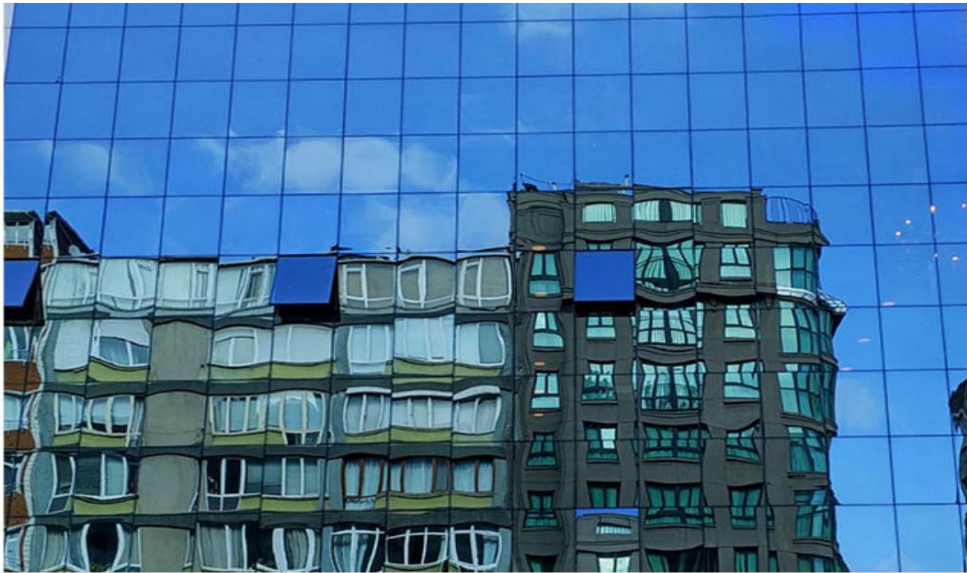
Изкривяване на образа при термична обработка на стъклото
