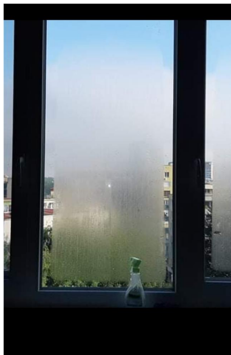
Конденз при стъклопакет с TPS дистанционер на Ролпласт
